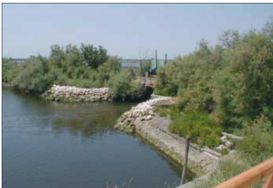
Un argine di delimitazione di una valle lagunare con il canale di ingresso dell'acqua salata regolato da una "chiavica", cioè una paratoia regolabile.
